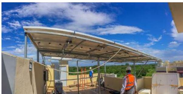
**Instalación de 68.3KWP** Sistema fotovoltaico de inyección a red.
